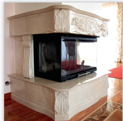
Wkład wodny trójstronny – wykonany specjalnie pod projekt, szymba w całości podnoszona do góry. Palenisko o mocy ~24 kW przystosowane do podłączenia w układzie zamkniętym. Wkład z zamkniętą komorą spalania. Zabudowa z marmuru, ręcznie rzeźbiona wykonana wg projektu powierzchniowego.
