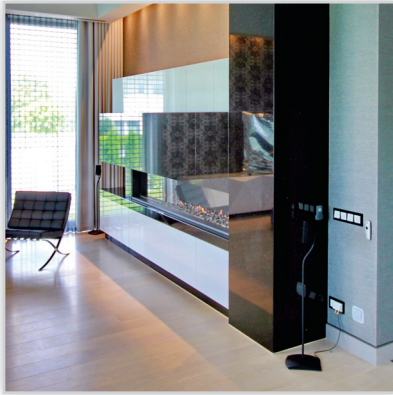
Kominek gazowy – wkład gazowy wykonany na zamówienie do tej konkretnej realizacji, szerokość wkładu 250 cm. Zabudowa wykonana z granitu Star Galaxy, białych elementów meblowych oraz spieku kwarcowego Laminam Filo Oro.
